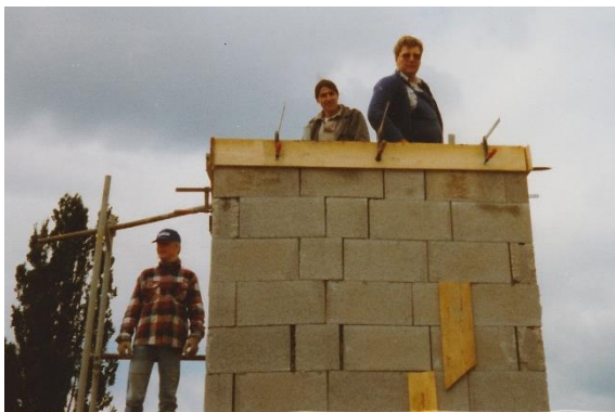
vlnr: Karl Steiner, Bernhard Forstner & Gerhard Forstner beim aufmauern des Schlauchturmes
