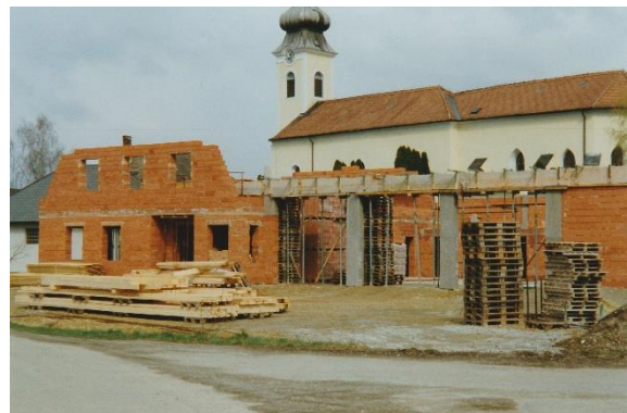
Rohbau im Jahr 1997
