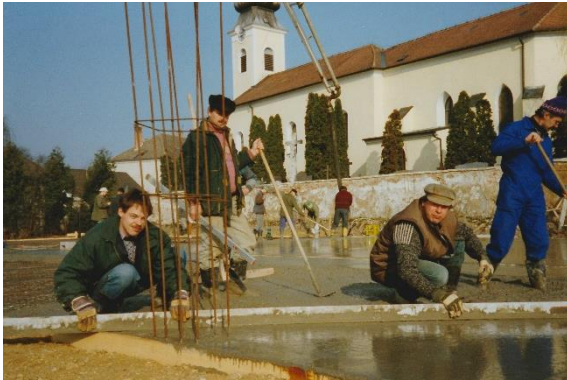
März.1997 Betonierung der Bodenplatte. vlnr: Günther Heberger, Franz Schmöllnerl, Leopold Anzböck, Franz Kerschl
